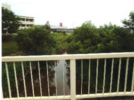
写真 33 No.11 地点 籠川 籠川橋
