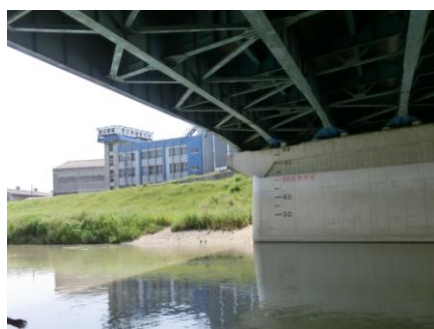
写真 59 No.27 地点 境川水系逢妻川 R1 逢妻大橋
