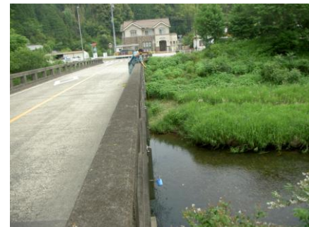
写真 38 No.13 地点 男川下流 学校橋 (採水)
