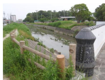
写真 52 No.22 地点 二の沢川 白妙橋
