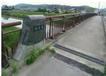
写真 45 No.17 地点 広田川 駒場橋
