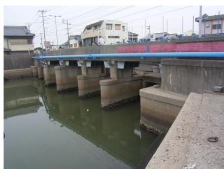
写真 55 No.23 地点 一色排水路 間浜橋
