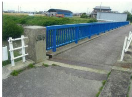
写真 42 No.16 地点 鹿乗川 北山橋
